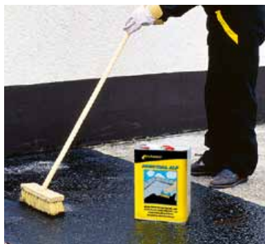
Penetrace pomocí pokrývačského kartáče.
