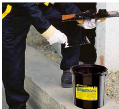
Po důkladném promíchání pomaluběžným míchadlem práškového tužidla (složka B) s asfaltovou hmotou (složka A) je materiál připraven k nanášení.
