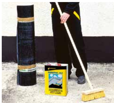
Před hydroizolací je třeba povrch důkladně očistit.
