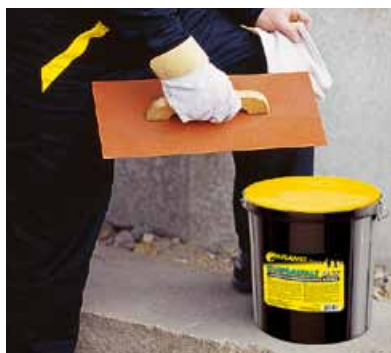
SA 27 se na kolmé stěny nanáší pomocí hladítka.
