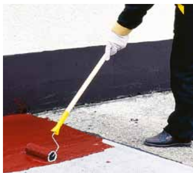
Aplikace SA 23 pomocí válečku.
