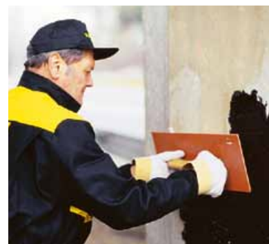
SA 27 se aplikuje zezdola nahoru. Nutné je nanesení nejméně jedné vrstvy o tloušťce 4 mm.
