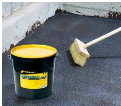
Gumoasfalt SA 12 se na penetrovaný beton nanáší pomocí pokrývačského kartáče nebo štětce.
