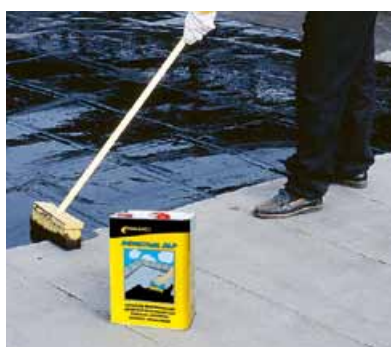
Obnovovací nátěr na staré krytiny Pentralem ALP.
