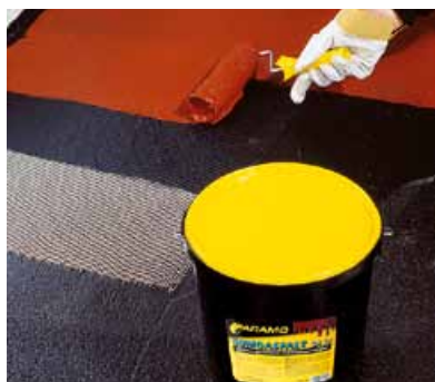
Vrchní krycí nátěr. Gumoasfalt SA 23, nanášení válečkem.
