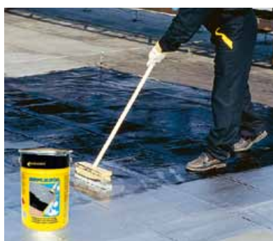
Vrchní nátěr asfaltolinikovým lakem Reflexol.
